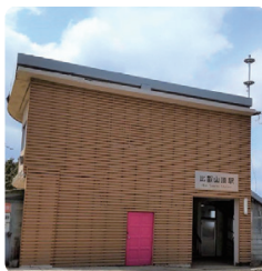
外観を整備した比叡山頂駅
