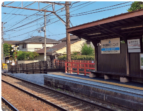
バリアフリー化工事完了後の車折神社駅下りホーム
