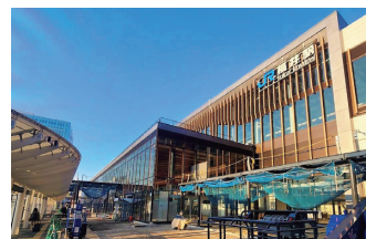
新幹線工事が進むJR福井駅東口
