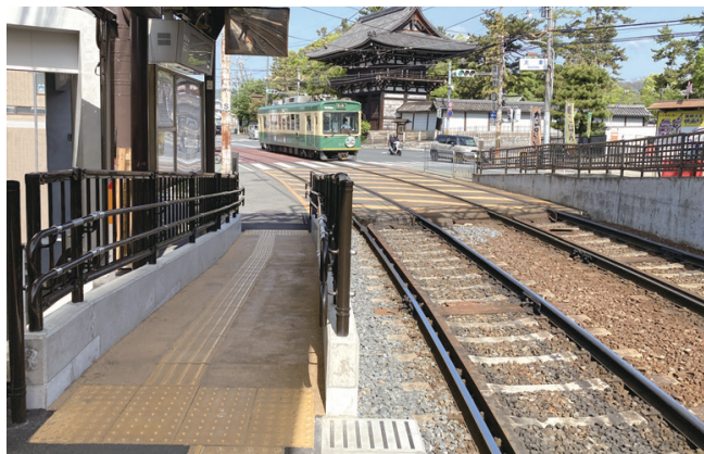
バリアフリー化工事が竣工した太秦広隆寺駅下りホーム
