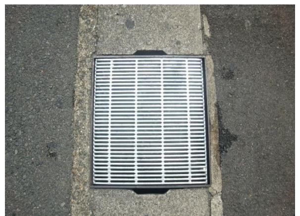
整備後の状況
