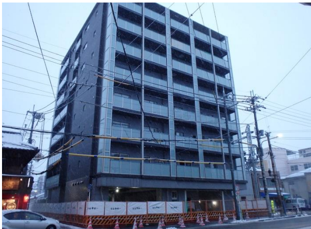
四条通側(建物南面)現況写真 (撮影:1月中旬)
