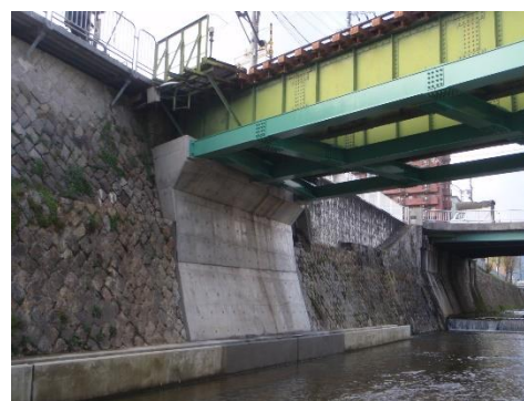
(写真：天神川橋梁耐震補強)
